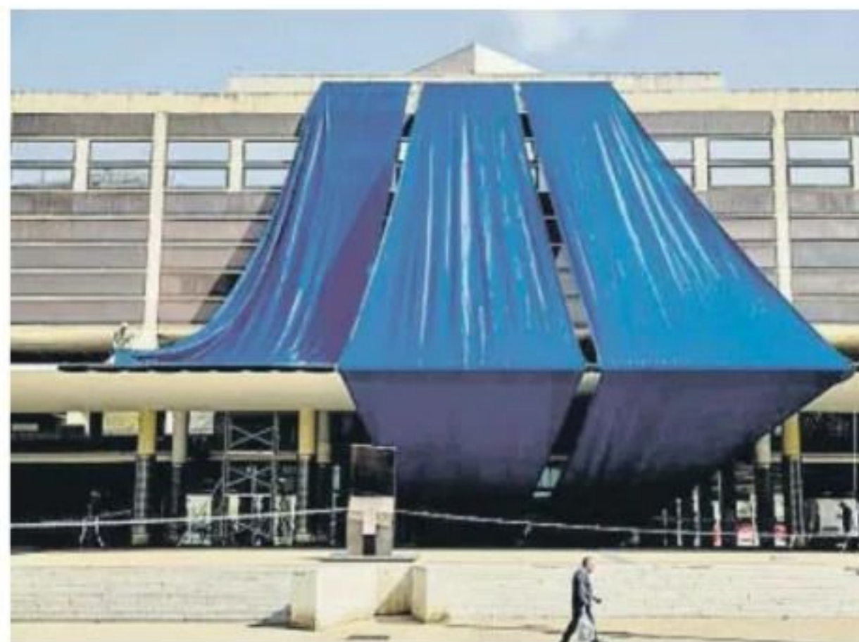
Operarios instalando ayer la intervención de Clara Solà-Morales
