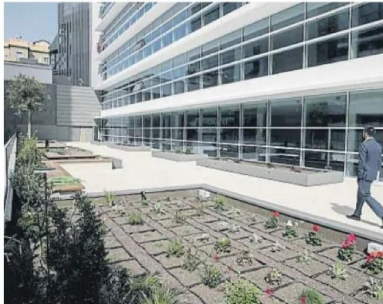
El complejo está abierto al exterior
